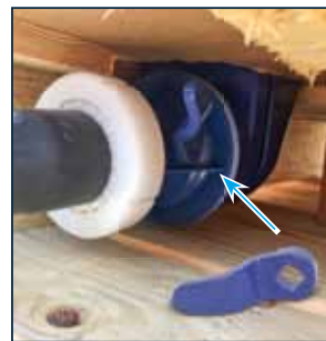
7. Plaats de blauwe sleutel op de sluiting en draai deze naar beneden om de sluiting te openen
